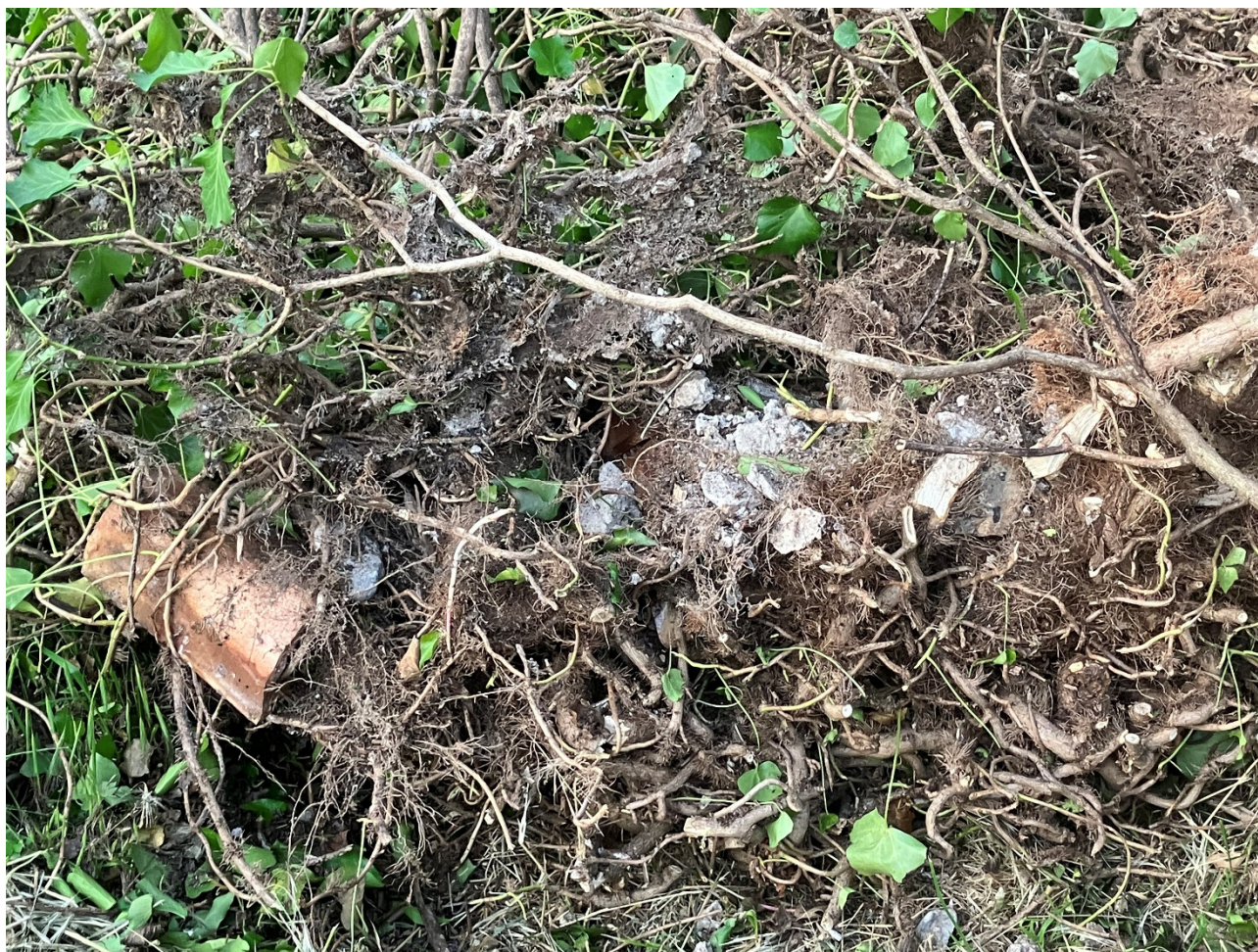
Fotografie 1 lavori sui muri ottocenteschi protetti
