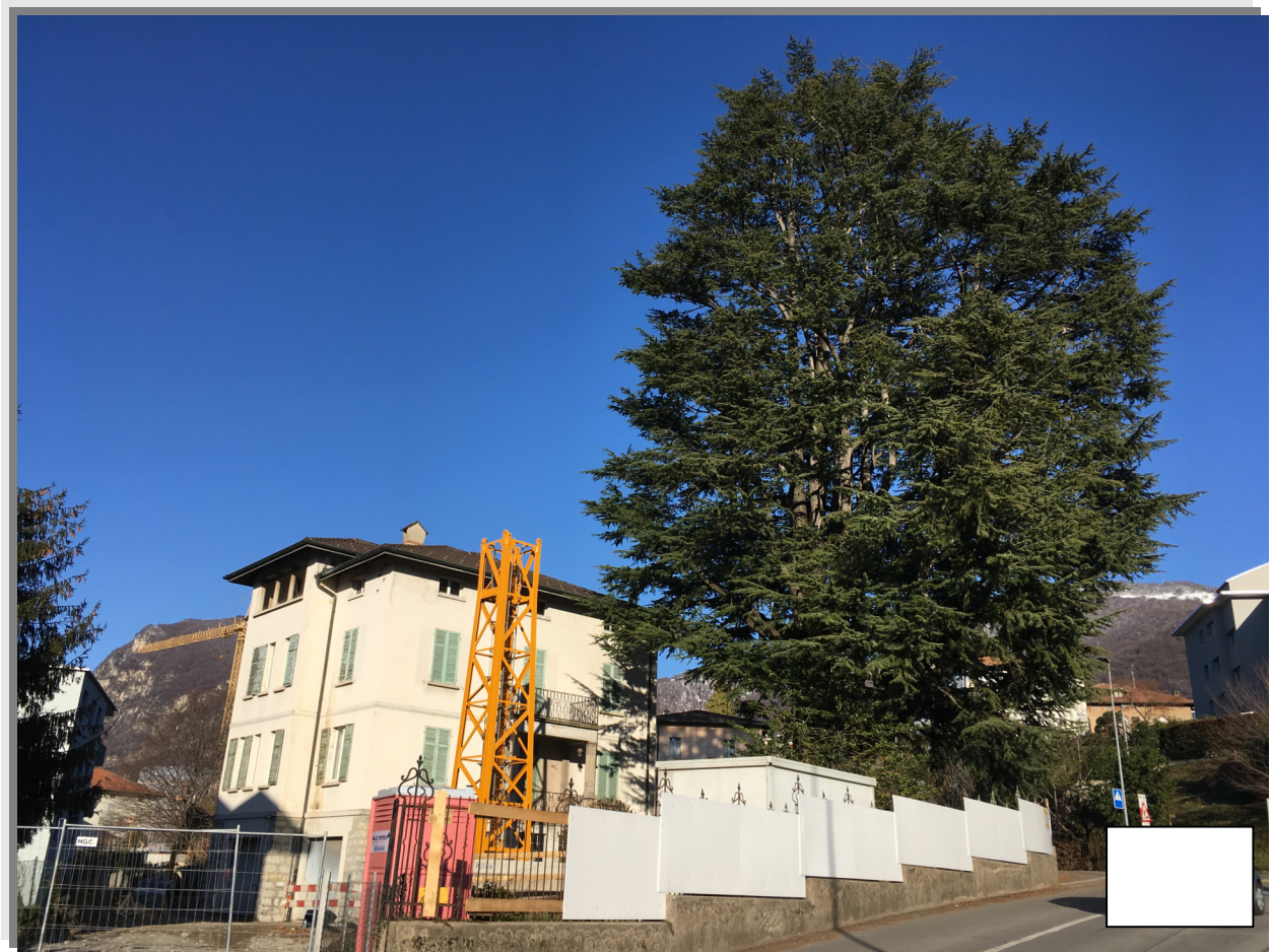
Posa di una prima parte di gru in data 7 gennaio 2021 (foto: 8 gennaio 2021)
